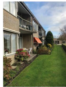
C: Woningen behorende tot naastgelegen woongebouw (2)
