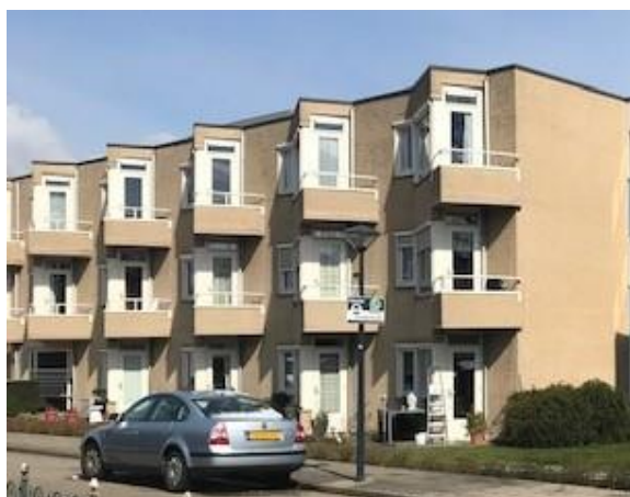
Afbeelding 9: Terrasjes en balkons aan de straatzijde, wooncomplex A. Foto: AiH.
