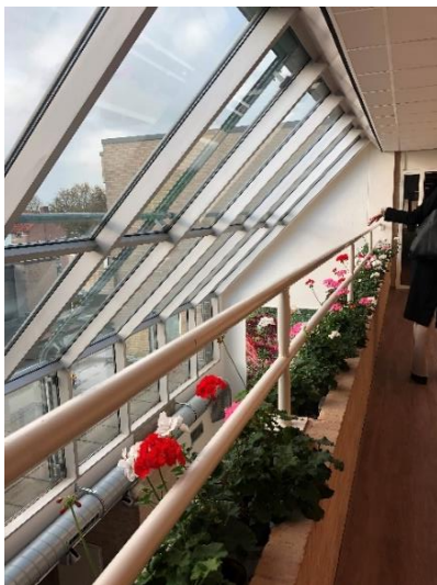
Afbeelding 7: Verkeersruimte verdieping, Casus A. Foto: AiH.
