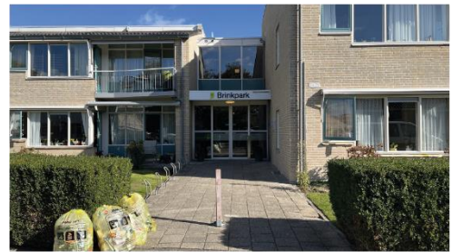
D: Eigen entree van naastgelegen woongebouw (2)
