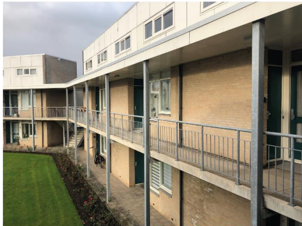
E: Galerijwoningen behorende tot naastgelegen woongebouw (2)
