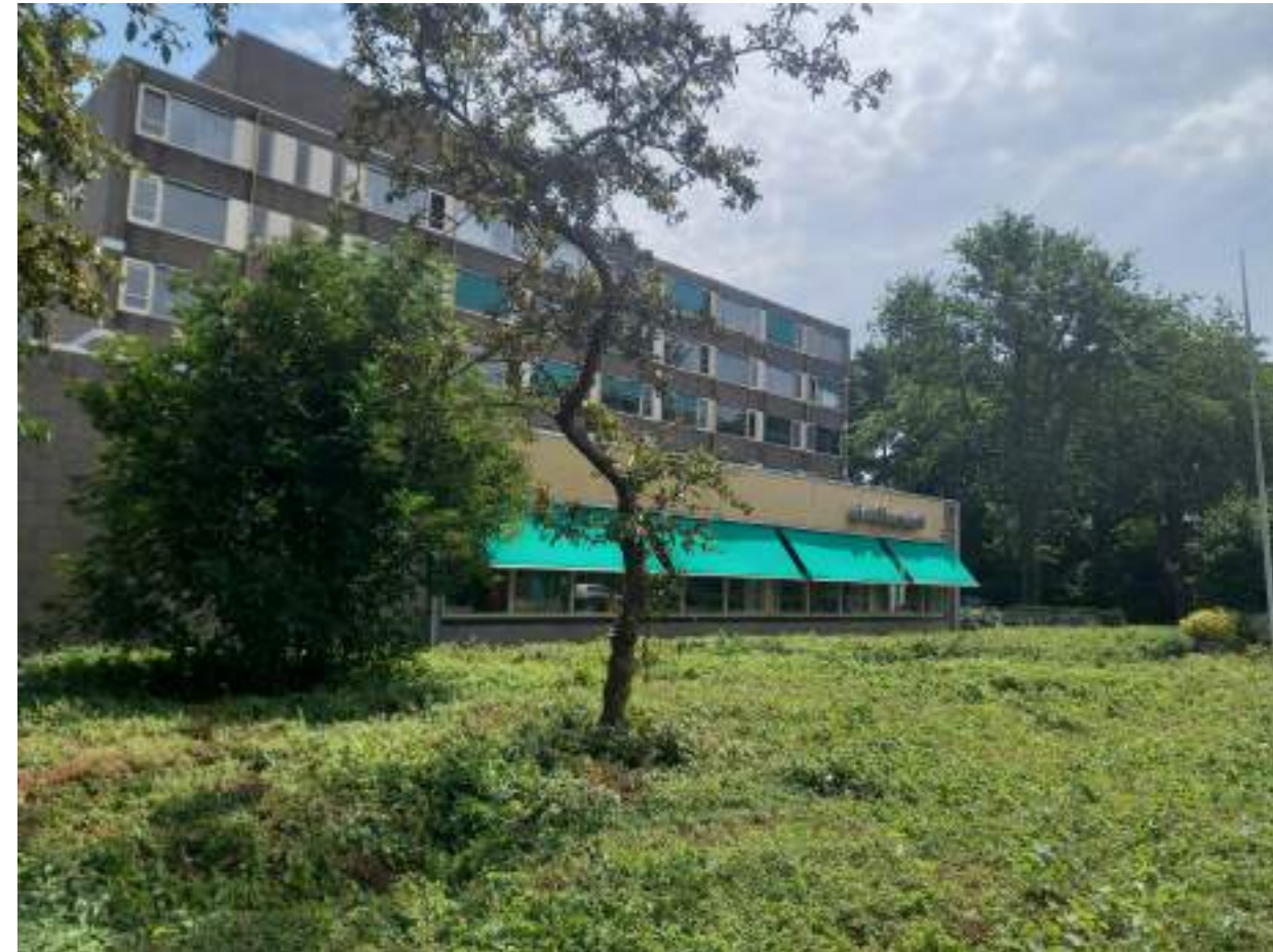
Olmenhof - te slopen gebouw
