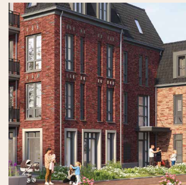
Via een regentuin, die een zachte en groene overgang naar het Remigiusplein vormt, wordt hemelwater afgevoerd en geïnfiltreerd in de bodem
