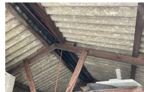
车库顶上的石棉水泥顶板
