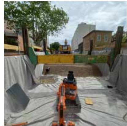
Figure 5 : Exemple d'une tranchée d'infiltration sous plateforme tramway
