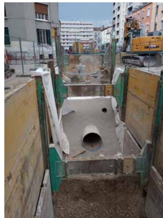
Figure 7 : Section d'une tranchée mutualisée
