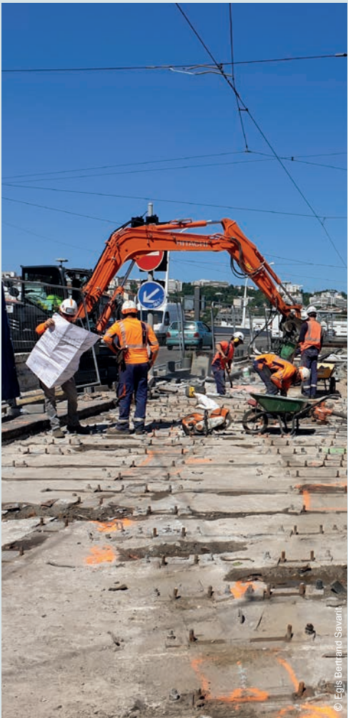
Lyon, renouvellement croisement T1-T2 Pont Gallieni
