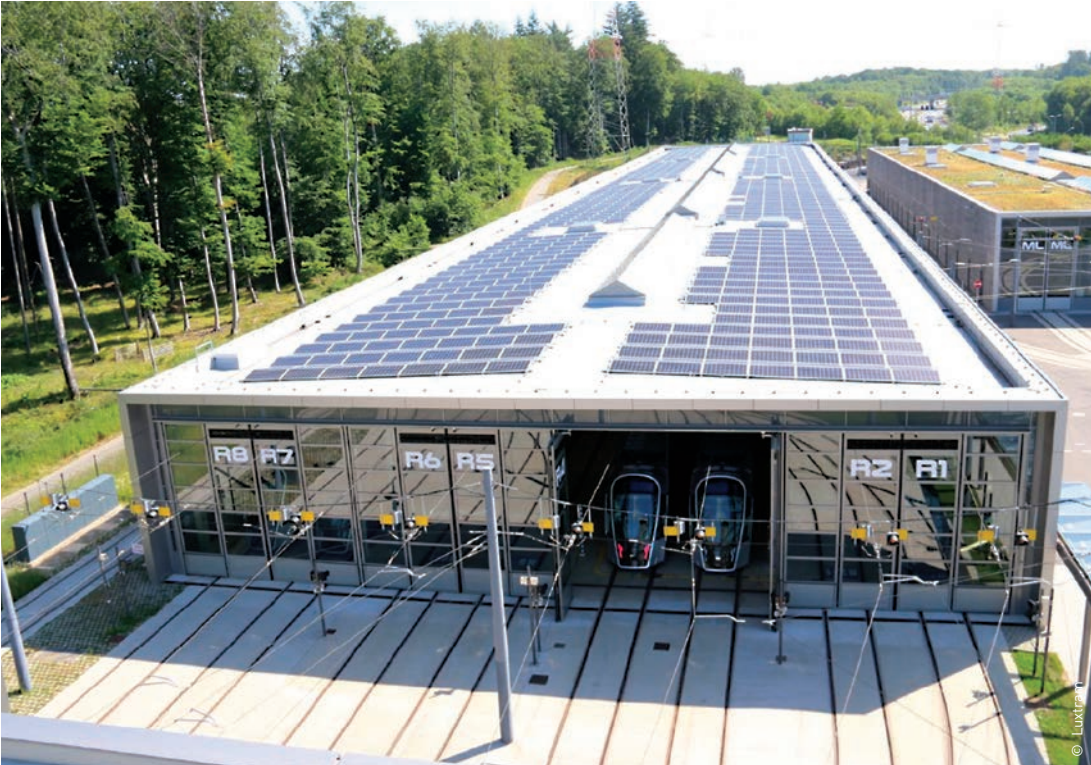
Centre de maintenance Tramway du Luxembourg
