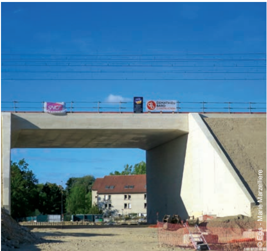
T12 Express, Epinay-sur-Orge, pont ferroviaire au dessus du Tramway
