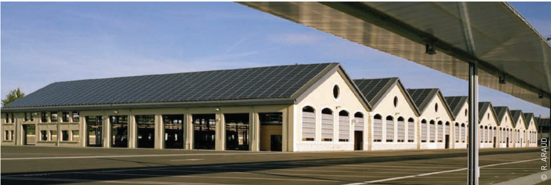
Centre de maintenance de Dijon Chenôve, ingénierie Egis - conception architecturale Ferrand-Sigal
