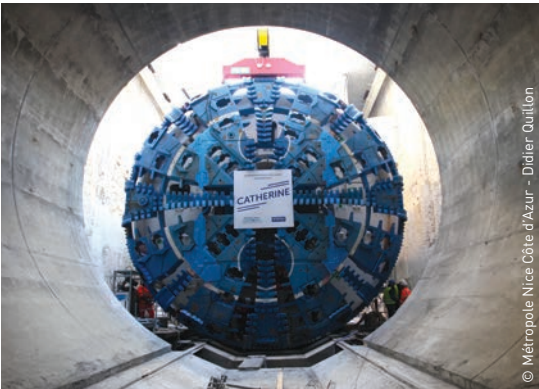
Nice ligne 2, section souterraine pour une desserte optimale du centre-ville
