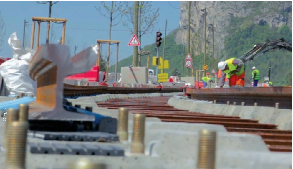
Grenoble, travaux sur le réseau de tramway
