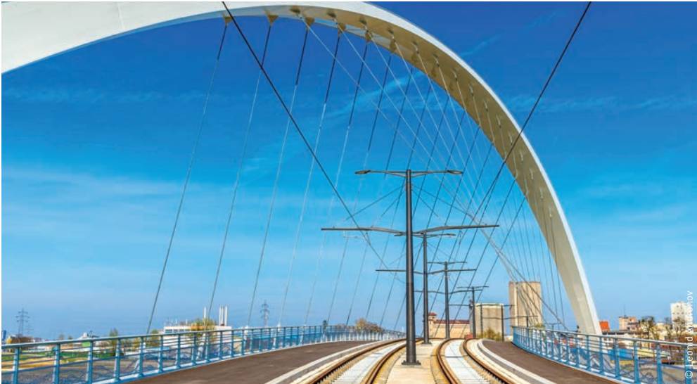
Strasbourg ligne D, Pont Citadelle au dessus du bassin Vauban
