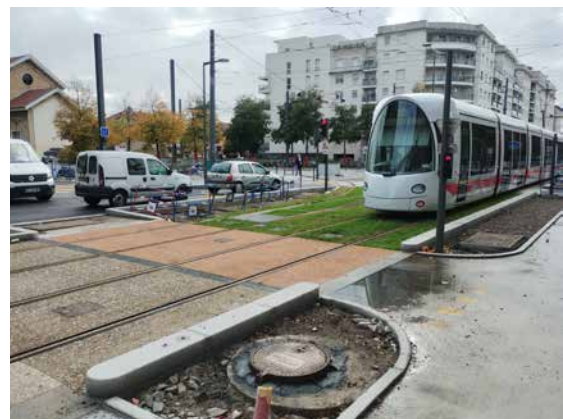
Aménagement cyclable accolé au tramway T6 avec orthogonalisation des conflits et signalisation tricolore adaptée.
