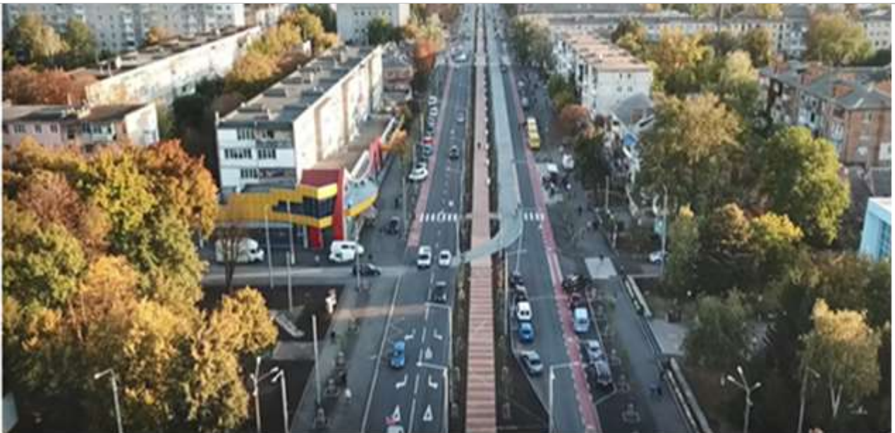
Рис. 6. Загальний вигляд на вул. Замостянську після реконструкції.[ 5].
