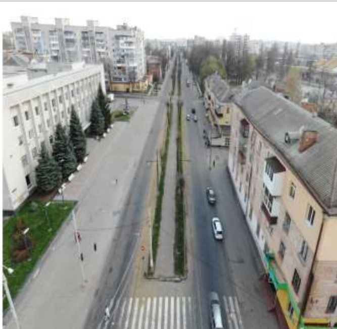
Рис.5. Фото вул. Замостянська до реконструкції [4].
