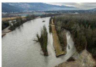
Recul de digue, ouverture de l'existante et reconnexion d'un bras mort (Lumbin) ©SYMBHI
