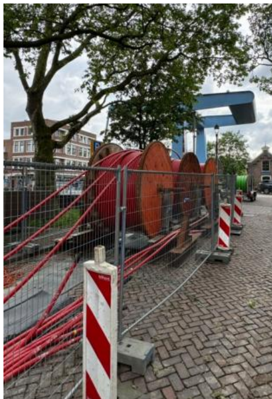
Foto: krappe opstelling van haspels bij kabellieren
