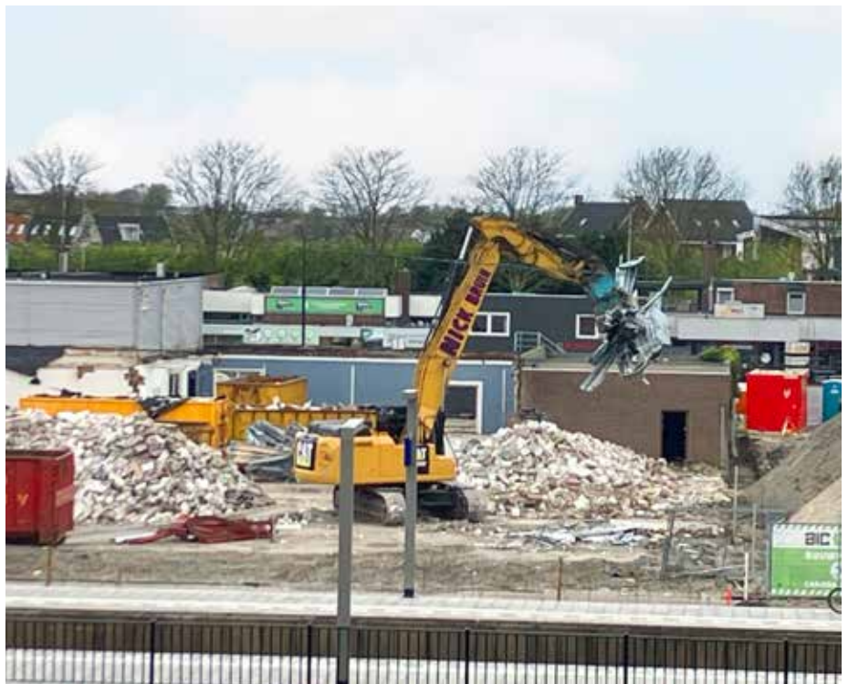
Een pand wordt gesloopt. In de toekomst moeten lego-achtige constructies zorgen dat gebouwen eenvoudig kunnen worden ontmanteld.
