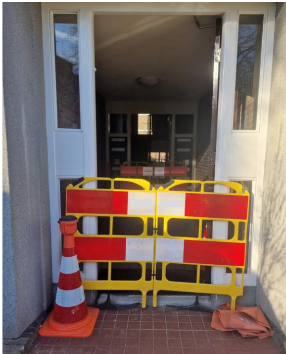
Foto: hal portiekflat met afzetting na het incident
