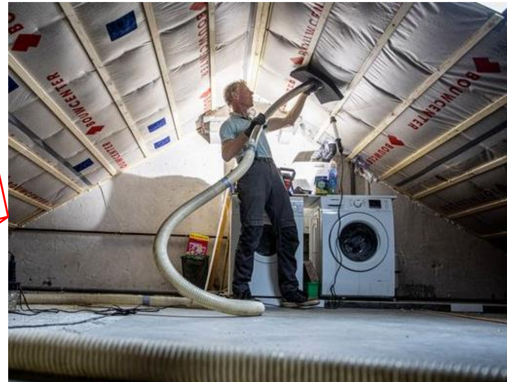
LOKAAL GETEELDE ISOLATIE 2023
