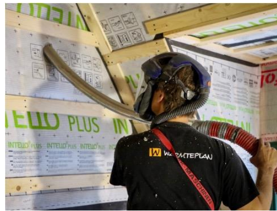
Inblazen vezels of cellulose achter luchtdichte folie
