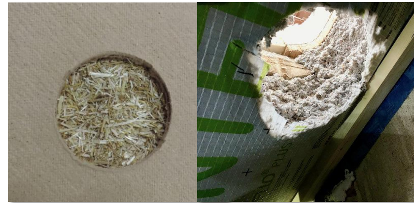
Inblazen vezels of cellulose achter luchtdichte folie
